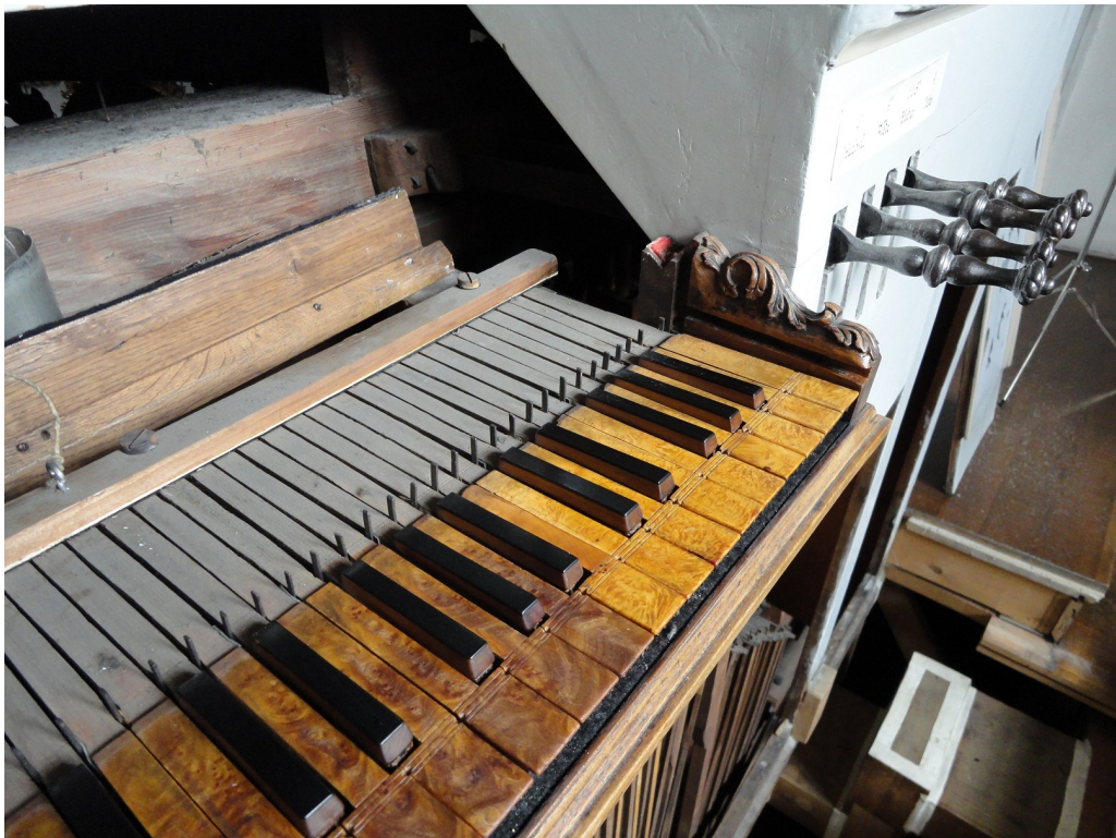
De Claviatuur van het orgel: de ondertoetsen zijn belegd met letterhout, in de gesneden bakstukken is een groef t.b.v. het klavierdeksel aangebracht. Naast het klavier zijn de hevels van de registermechaniek zichtbaar.
