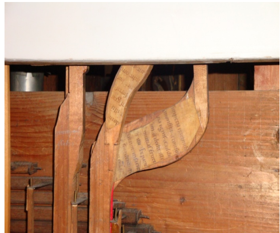
Treklatten van de registermechaniek, overzet en met perkament verstevigd
